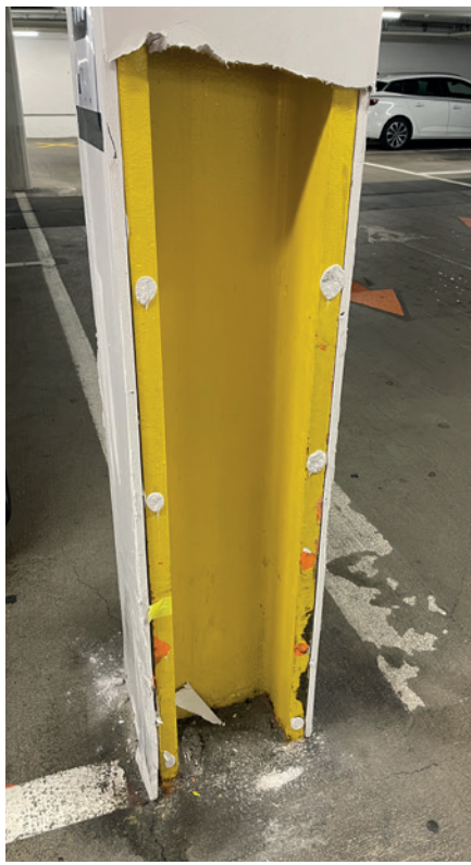
Auch bei den Stützen stand der Brandschutz im Fokus..
