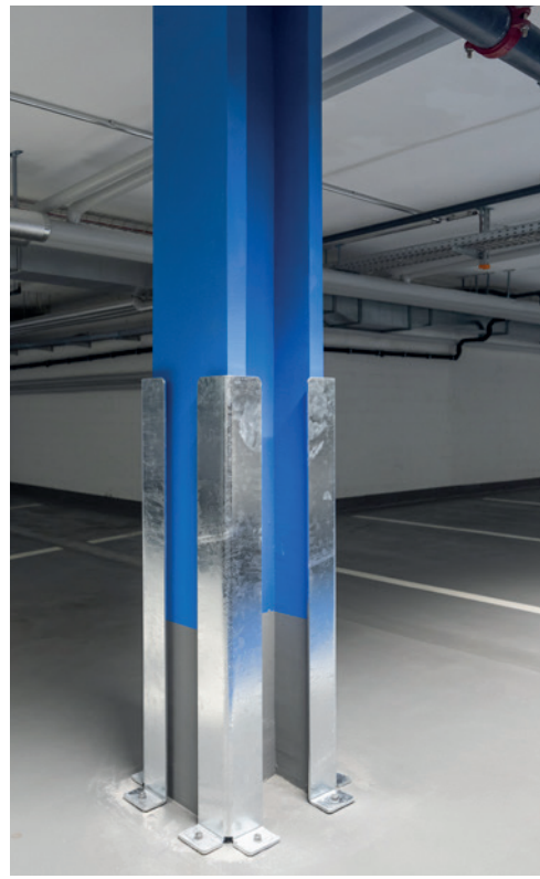
Stahlträger nach der Sanierung – mit Schutzbeschichtung..
