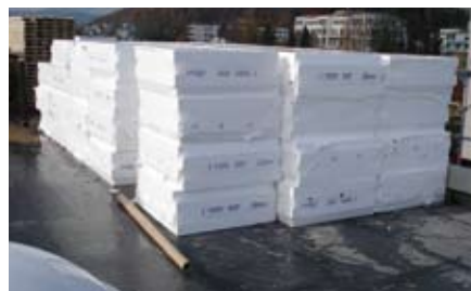
Auf die Bauzeitabdichtung wurden S-Therm Wärmedämmplatten verlegt.
