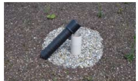
Mittels Kontrollrohr kann das Dach jederzeit auf Dichtigkeit überprüft werden.
