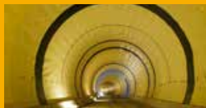
ABDICHTEN IM ERDREICH / GEWÄSSERSCHUTZ
