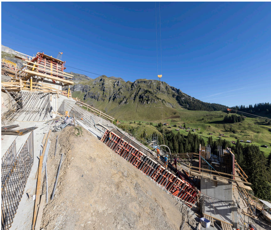
Bauarbeiten an der 2. Sektion, Stütze 3, in der Sektion Mürren-Birg.
