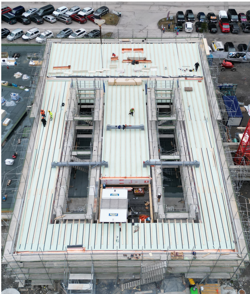
Talstation Stechelberg: Zu sehen ist die verarbeitete Unterdachbahn Sarnafil® S 352 TEX und wie die Konterlatten als Hinterlüftungsebene aufgeschraubt werden.
