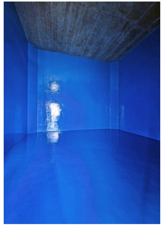
Schutzbeschichtung des Trinkwasserreservoirs auf dem Schilthorn.
