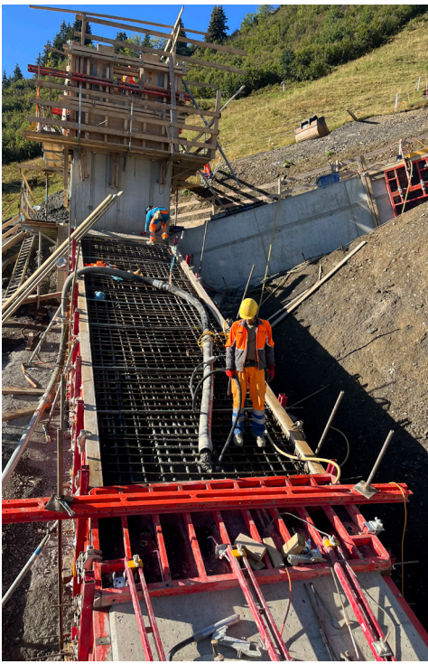
Pumpbetonarbeiten bei Stütze 3.
