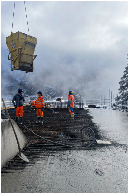
Winterbetonieren bei Minustemperaturen.
