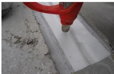
Il nastro Sikadur Combiflex® SG può essere adattato all'andamento del giunto riscaldandolo con attenzione con un fon ad aria calda.
