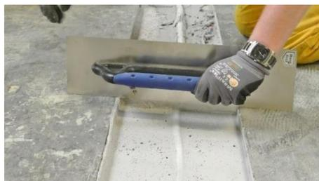
Posizione centrale del profilo di tamponamento a contatto diretto con il nastro di mascheratura (strato di separazione) sulla parte inferiore dei pannelli a pavimento.
