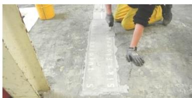
Per terminare, colmare i bordi con l'adesivo di sistema Sikadur® servendosi di una spatola.
