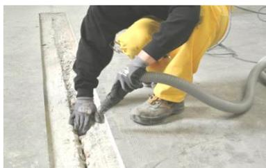
Prima di mettere in opera l'adesivo di sistema Sikadur®, rimuovere accuratamente la polvere e le parti incoerenti, di preferenza con una spazzola e un aspirapolvere industriale.
