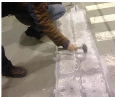
A garanzia della qualità, si raccomanda di controllare i pannelli per assicurarsi che non sia stata inclusa aria, di preferenza subito dopo la posa oppure una volta colmati i bordi.
