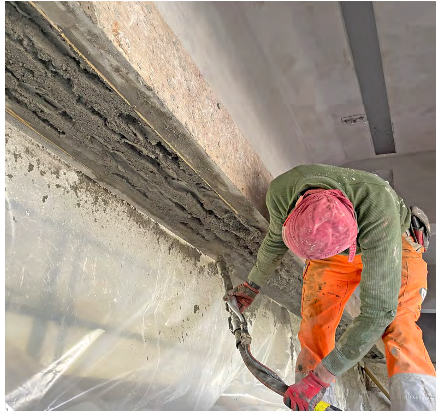
7 Kombination von Sika® CarboDur® mit re-plate 8 re-bar eingelegt im Sika MonoTop® (Brandschutz dank Mörtelüberdeckung) 9 Vermörtelung des Mittelbereiches mit Sika MonoTop® 10 Schubverstärkung/Verankerung mit re-bar U-Bügel 11 Oberflächenfinish und Fertigstellung
