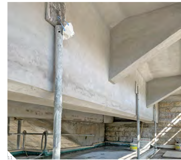
7 Kombination von Sika® CarboDur® mit re-plate 8 re-bar eingelegt im Sika MonoTop® (Brandschutz dank Mörtelüberdeckung) 9 Vermörtelung des Mittelbereiches mit Sika MonoTop® 10 Schubverstärkung/Verankerung mit re-bar U-Bügel 11 Oberflächenfinish und Fertigstellung
