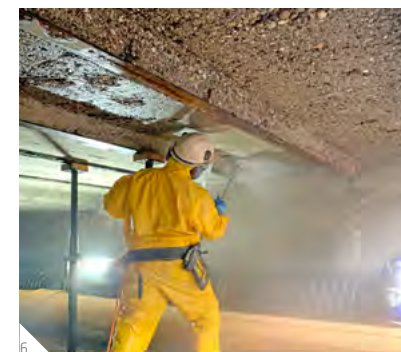
4 60-jährige Betonbrücke 5 Betonabplatzungen und korrodierte Innenbewehrung 6 Hydromechanisches Abtragen des schadhaften Betons und Aufrauen
