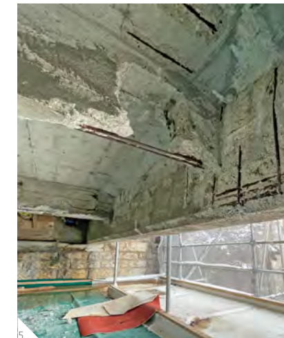
4 60-jährige Betonbrücke 5 Betonabplatzungen und korrodierte Innenbewehrung 6 Hydromechanisches Abtragen des schadhaften Betons und Aufrauen
