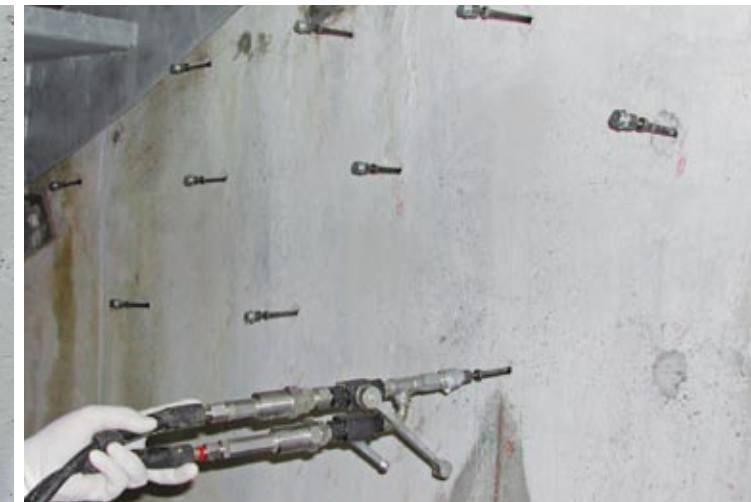
Schleierinjektion mit Sika® Injection -304
