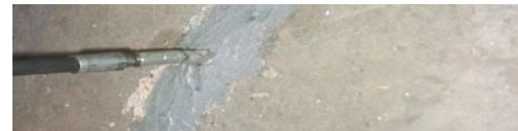
Kraftschlüssige Rissinjektion mit Sikadur®-52 Injection
