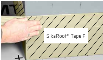
SikaRoof® Tape P am Kamin anbringen.
