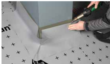
SikaRoof® MTP Eckanschluss universal positionieren und aufkleben.
