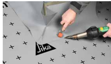
SikaRoof® MTP Eckanschluss universal mit der Unterdachbahn verschweissen.
