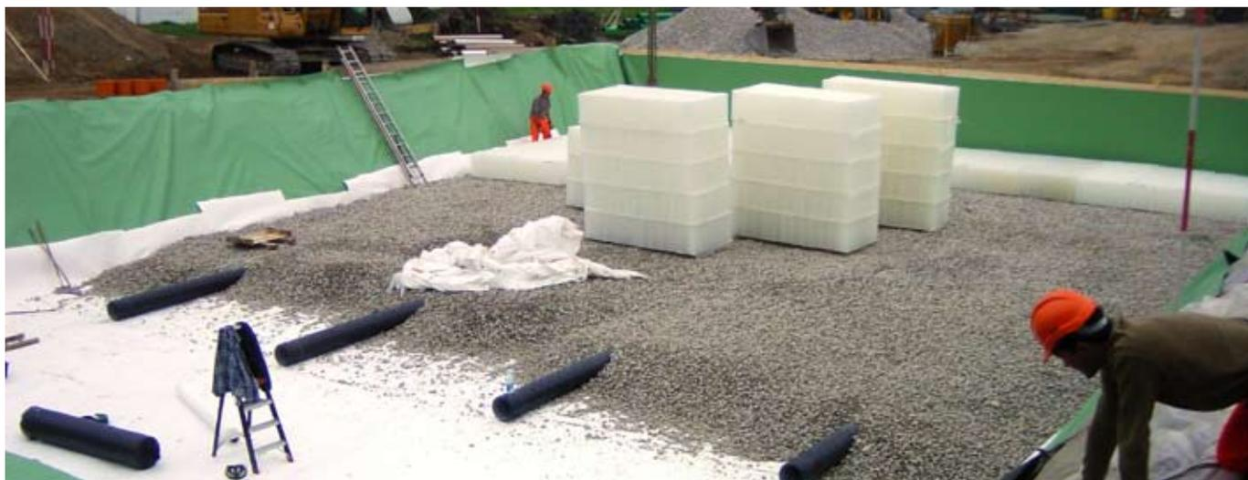
Verlegen der Nidaplast Blöcke in das mit Sikaplan-Kunststoff-Dichtungsbahnen abgedichtete Retentionsbecken.
