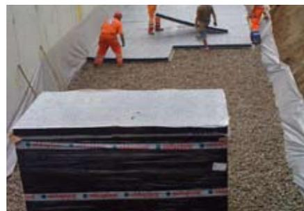
Versickerungsmodul angeordnet neben dem Filterbecken. Das Oberflächen- und Dachwasser aus dem Quartier wird wieder dem natürlichen Kreislauf abgegeben.
