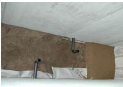
Blick in das Filterbecken: Einlaufrohre für das Wasser aus dem Retentionsbecken. Spezialsubstrat für die Reinigung des Wassers.
