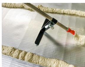
6. Appliquer le SikaRoof® Board Adhesive par bandes sur le support. Presser rapidement les plaques d'isolation thermiques sur la mousse. (temps ouvert: environ 3-4 minutes).
