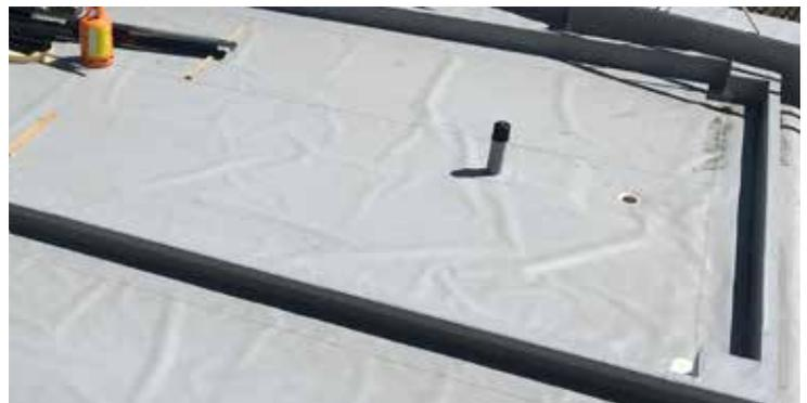
Dank den mit Sarnafil-kaschierten Blechen konnten die Öffnungen separat abgetrennt und sauber abgedichtet werden.
