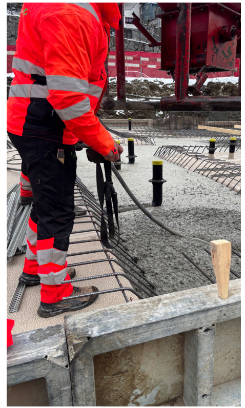
Verlegen SikaProof® A+ Abdichtungssystem.
