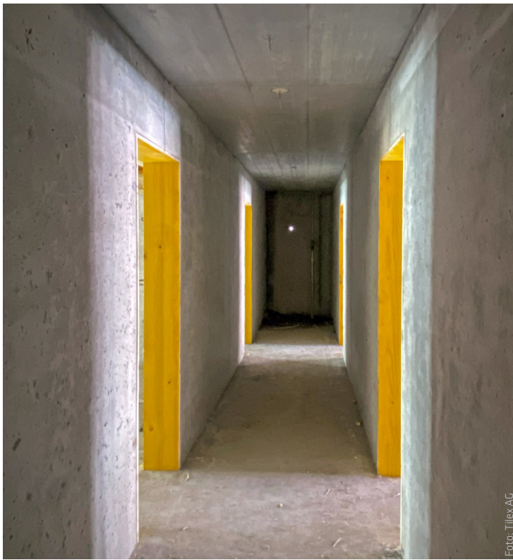
Wände realisiert mit RC-M 40 und SikaFiber® Force.
