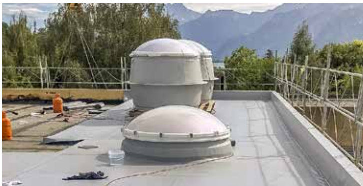
Dank den praktischen Formteilen konnten die Kuppeln schnell und effizient abgedichtet werden.
