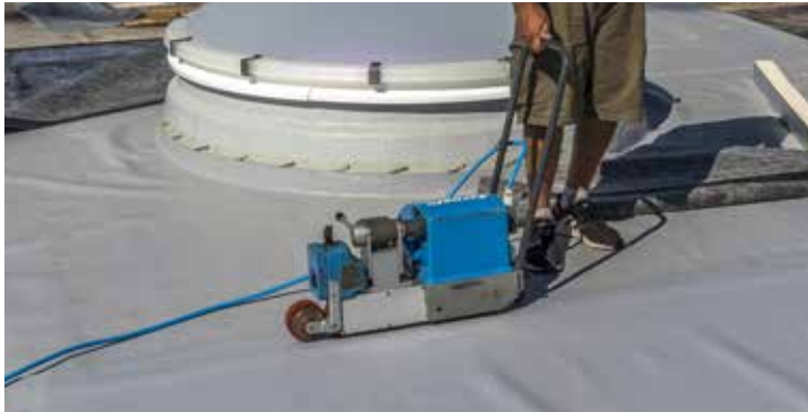
Dank der thermischen Verschweissung – mit dem Sarnamatic oder per Handschweissgerät – kann SikaRoof AT auch Holzbauten gefahrenfrei abdichten.
