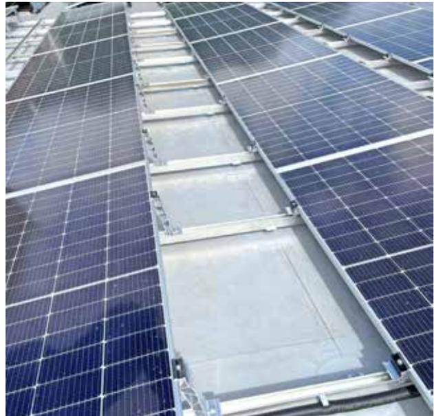
Grazie alla filettatura interna M12 è possibile posare facilmente sul sistema SikaRoof® Anchor un'ampia gamma di strutture fotovoltaiche.
