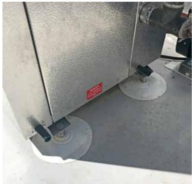
Posa versatile di diverse apparecchiature e dispositivi sul sistema SikaRoof® Anchor.
