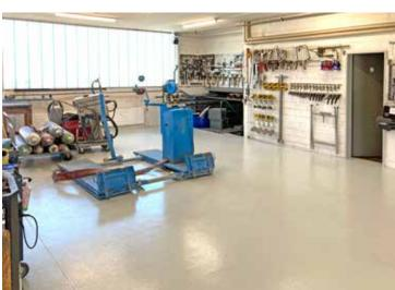
Nach der Applikation der Einstreuschicht konnte ab 13.00 Uhr bereits der überschüssige Sand entfernt und die Fläche überschliffen werden. Anschliessend wurde der Kopfsiegel Sikafloor®-2640 aufgebracht.
