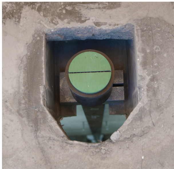
Bild 04: Aufsicht Verankerung Dachgeschoss
