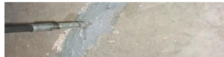
Injection de fissures définitive avec Sikadur®-52 Injection
