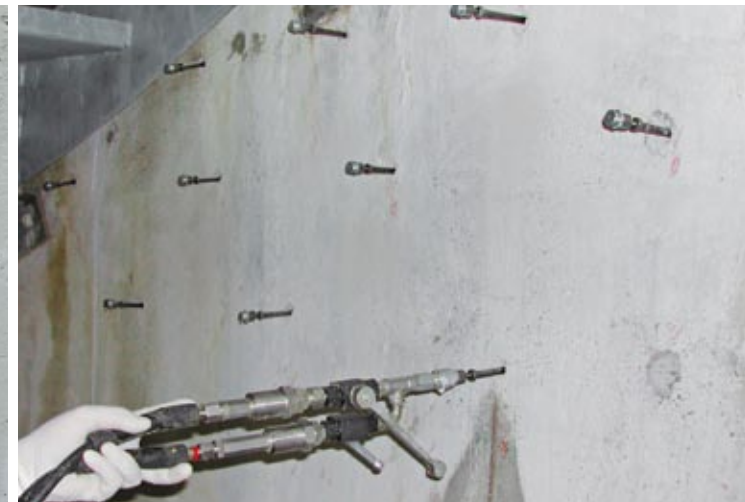
Injection d'étanchement avec Sika® Injection -304
