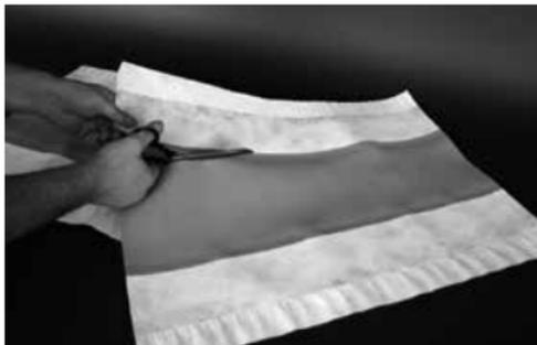
Couper en longueur la bande Sika® Dilatec® B (≥ largeur de bande) et couper le bord de non-tissé sur un côté.
