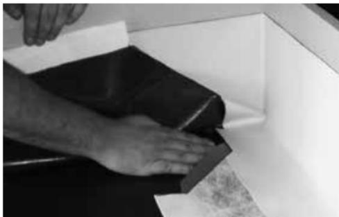
**Découpe de la bande de soudure pour angle intérieur**
