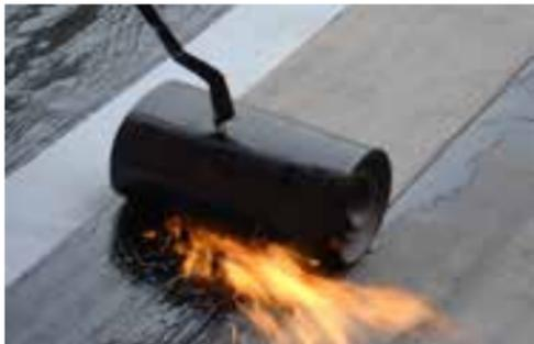
Appliquer la deuxième couche ou une bande supplémentaire de 30 cm de large de la membrane d'étanchéité bitumineuse. La zone de dilatation est ainsi recouverte sur 1 à 2 cm.
