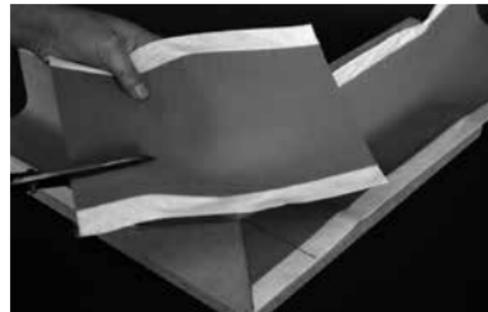
Couper le matériau manquant de la bande Sika® Dilatec® E correspondant et couper le bord de non-tissé sur un côté.
