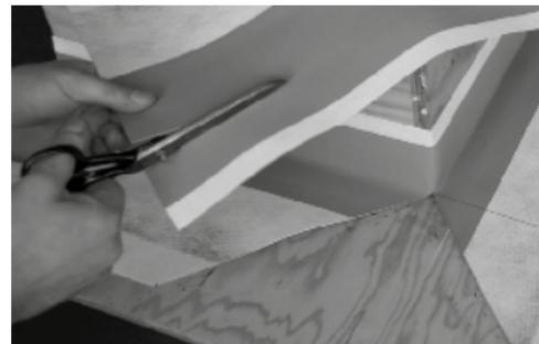
Couper le matériau manquant de la bande Sika® Dilatec® BE correspondant et couper le bord de non-tissé sur un côté.
