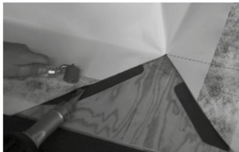
**Découpe de bande de soudure pour raccord en T**
