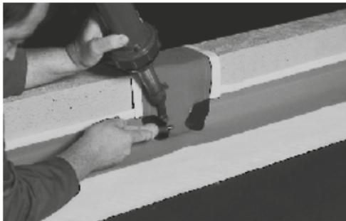
**Bande de soudure pour raccord en T**
