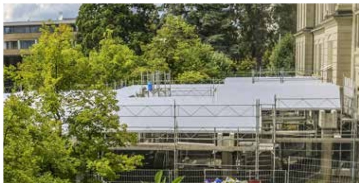
Das imposante "Vordach" vor dem historischen Gebäude musste innerhalb der Ferienzeit neu abgedichtet werden!
