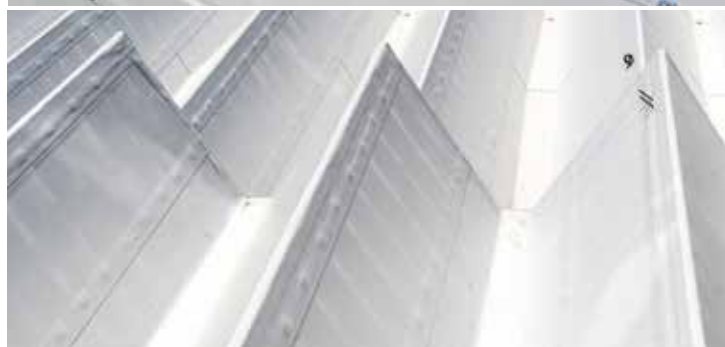
Die mechanische Befestigung der Abdichtung auf die vorgefertigte Beton-Unterkonstruktion und die homogene thermische Verschweissung gewährleistet, dass das Dach für viele Jahrzehnte dicht bleibt.
