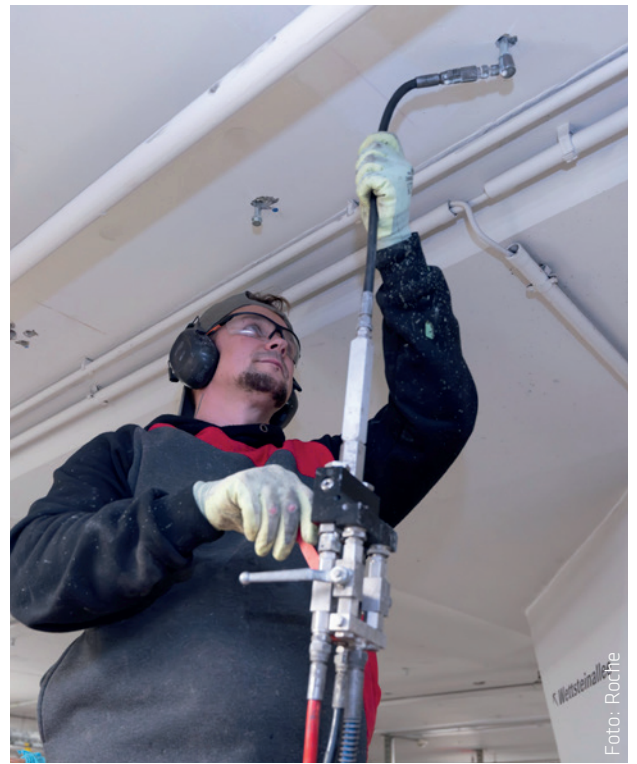
Neues Verfahren: Sanierung von Betondecken per Schleierinjektion.
