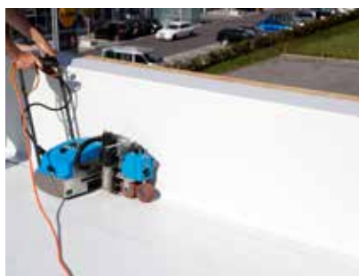
5. Terminer par un soudage thermique avec la membrane de toiture.
