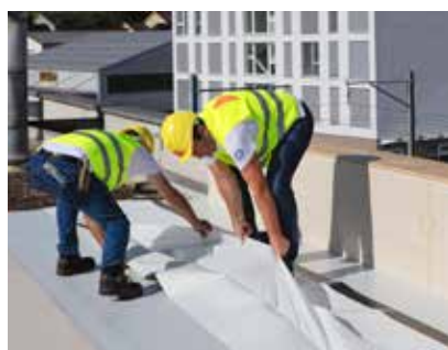
1. Positionner et retirer le liner de SikaRoof AT FSA P.
