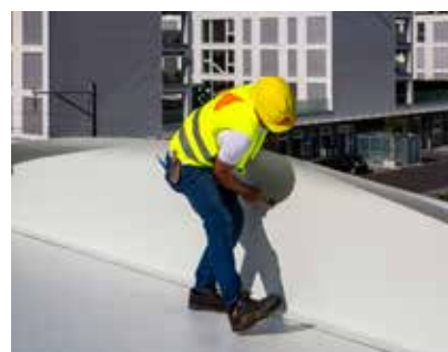
3. Positionnement et collage de la membrane autocollante.
