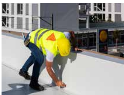
4. Passer un rouleau sur la membrane autocollante pour obtenir un collage sans vide.
