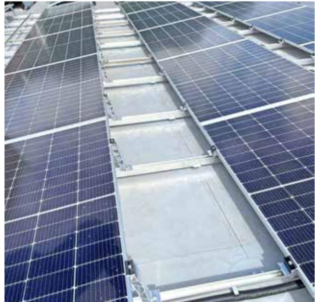
Aufgrund des M12 Innengewindes ist es einfach, eine breite Auswahl an Solarkonstruktionen auf das SikaRoof® Anchor System zu bauen.
