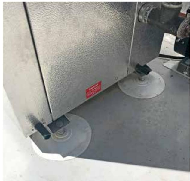
Vielseitige Installation von verschiedenen Vorrichtungen / Ausrüstungen auf das SikaRoof® Anchor System.
