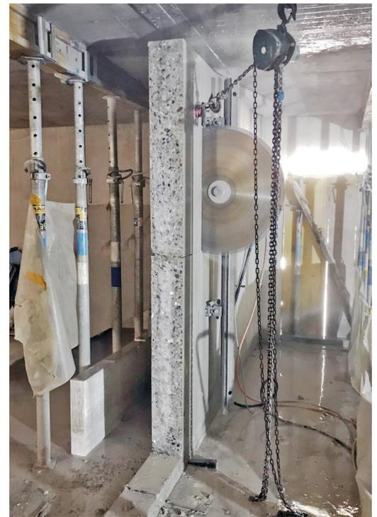
Foto Betonkreissäge: Diamcoupe SA
