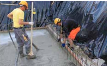
*Betonieren der Bodenplatte*
