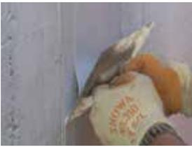
Auf den vorbereiteten Untergrund wird eine Schicht Sikadur-Combiflex® CF Kleber zur Aufnahme des Bandes appliziert.
