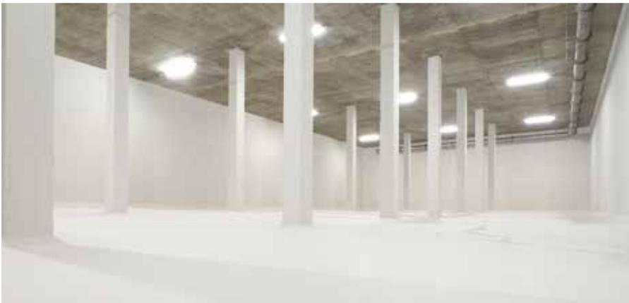
*Zementgebundene Beschichtung als Reservoirauskleidung*
