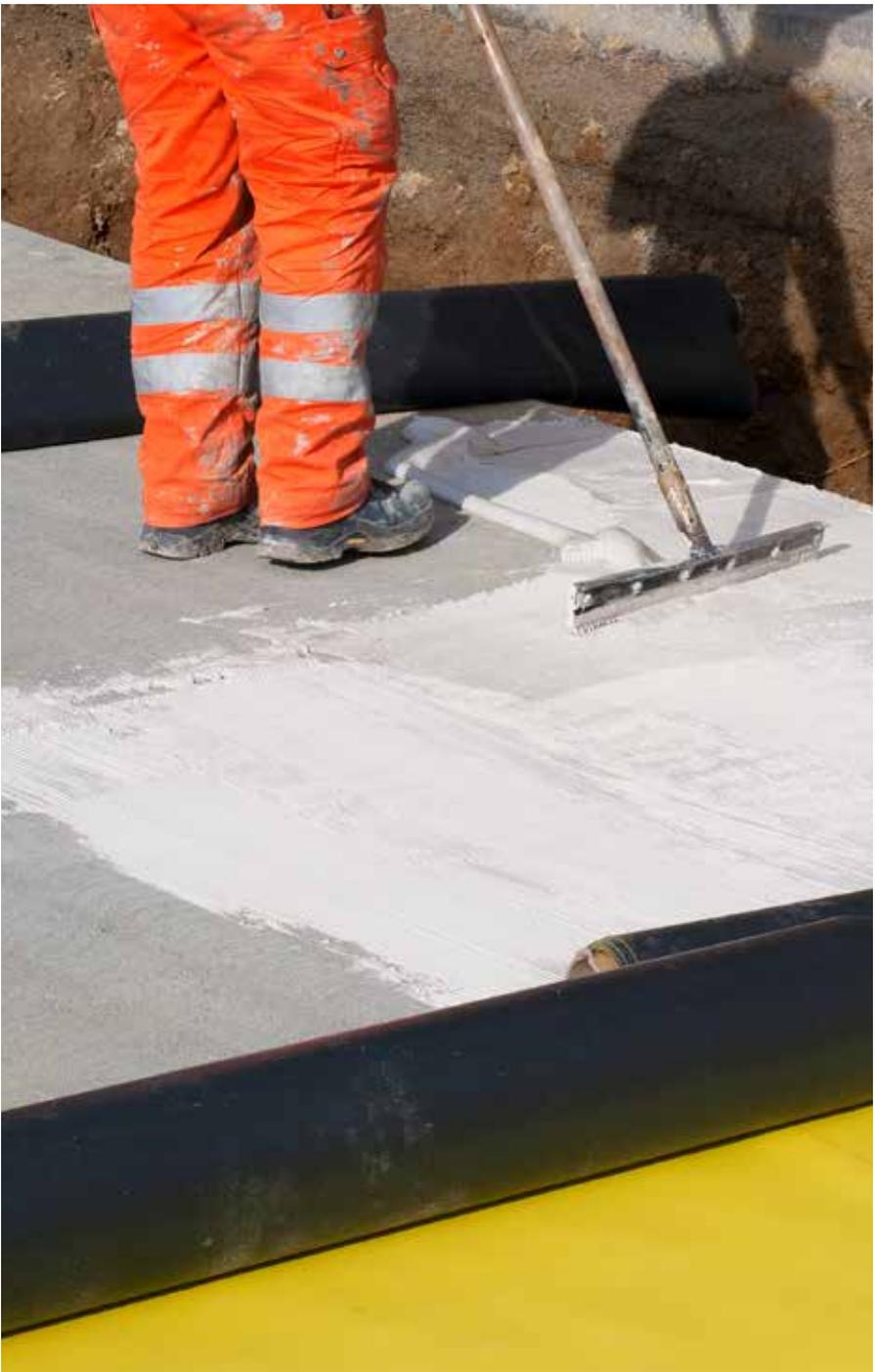
*Vollflächige Verklebung von Kunststoffdichtungsbahnen*
