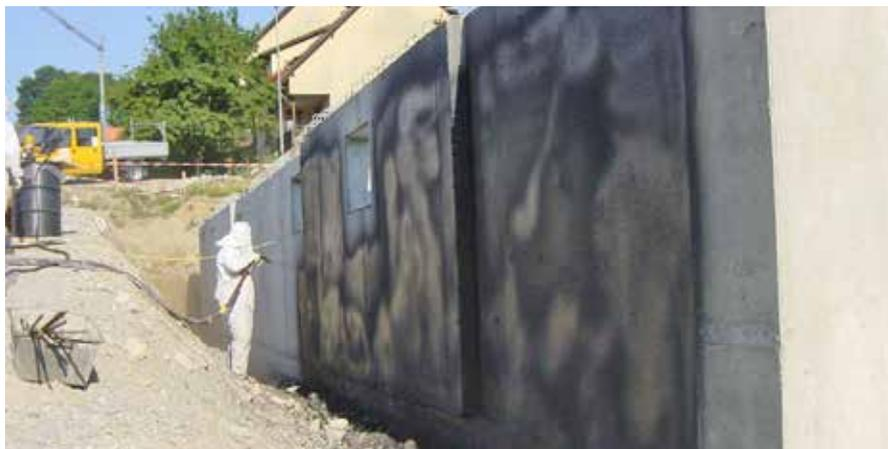
Auftrag von kunststoffmodifizierter Bitumendickbeschichtung
