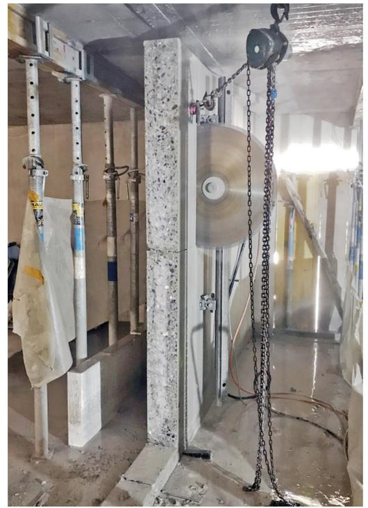
Photo scie circulaire à béton : Diamcoupe SA
