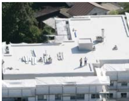
Die Sarnafil Kunststoffdichtungsbahnen sind schnell verlegt, werden thermisch verschweisst und unterstützen so einen effizienten Bauablauf.
