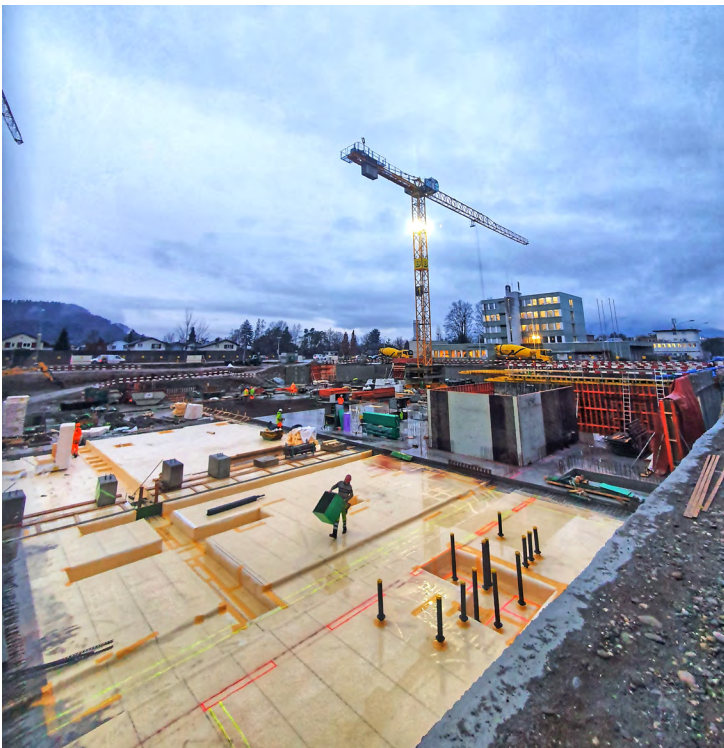
Frischbetonverbundabdichtung mit dem SikaProof® A System.
