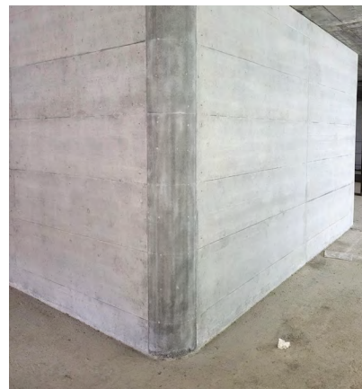
Beim Bauprojekt Untersiggenthal waren alle Arbeiten in Sichtbeton Typ 4.1.4 mit hohen Anforderungen (BOK 2 und 3) auszuführen.
