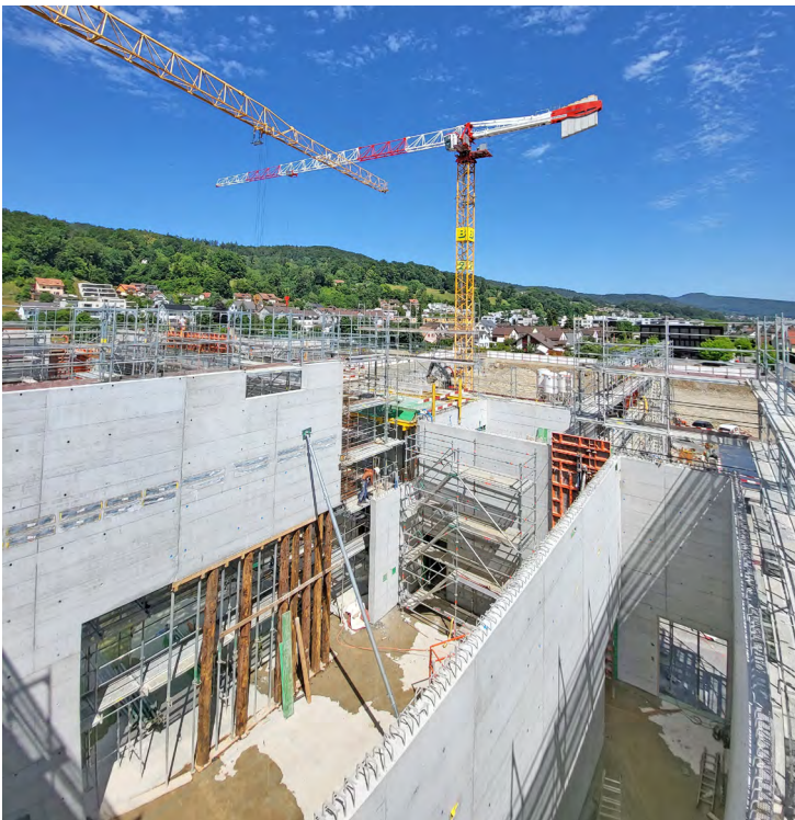
Die Turn- und Mehrzweckhalle wurde als wasserdichtes Bauwerk mit erhöhten Anforderungen an Sichtbeton und Frischbetonkonsistenzen gebaut.
