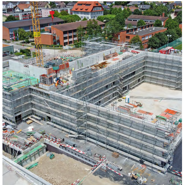
Die Turn- und Mehrzweckhalle wurde als wasserdichtes Bauwerk mit erhöhten Anforderungen an Sichtbeton und Frischbetonkonsistenzen gebaut.
