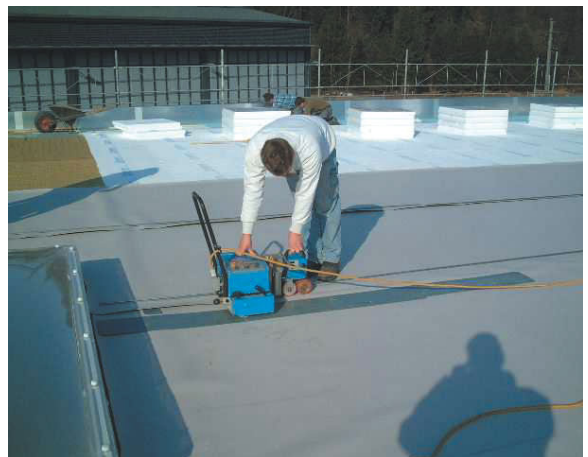
Verschweissung mit Heissluftschweissautomat
