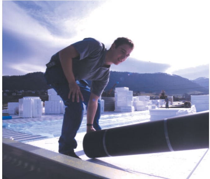
Verarbeitung abgelängter Sarnafil Rollen
