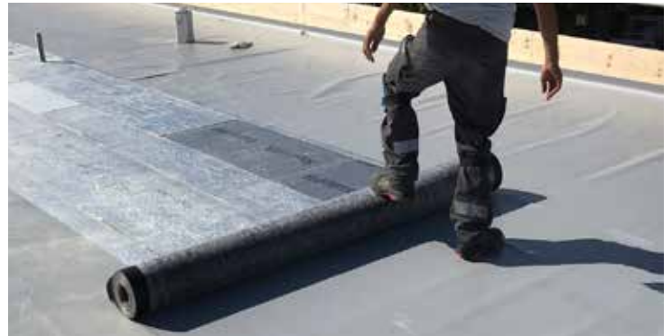
Ausrollen, thermisch verschweissen, dicht - so einfach gehts mit der Hybrid-TPO-Abdichtung SikaRoof AT.
