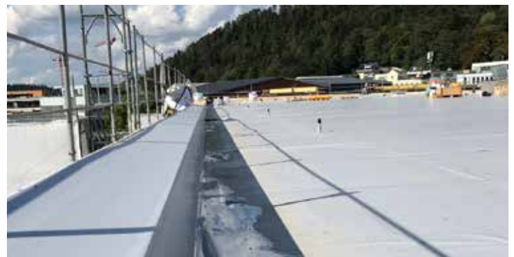
Mit der innovativen Selbstklebebahn SikaRoof AT FSA P wurden die Aufbordungen hohlraumfrei um alle Kanten, sauber und effizient ausgeführt.
