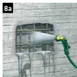
**8a** **Humidification de la surface du béton jusqu'à saturation des pores.**
