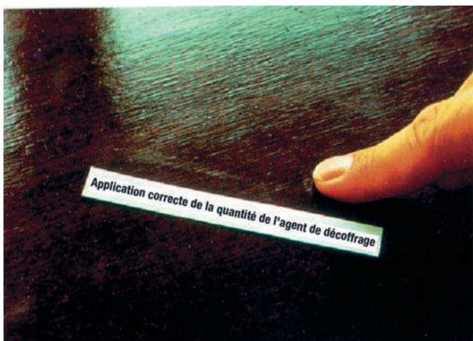
Application correcte de la quantité de l'agent de décoffrage.
