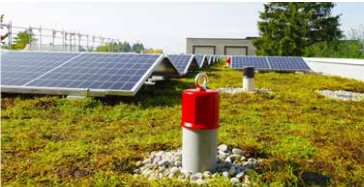
Dank dem Seculine Vario Seilsicherungssystem kann das Dach in Hinwil jederzeit sicher kontrolliert und die Unterhaltsarbeiten ohne Gefahr erledigt werden.
