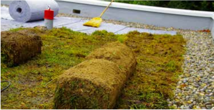
Auch bei der Begrünung ging man einen innovativen Weg und wählte eine leichte Rollbegrünung.
