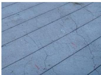
Im Gegensatz zu anderen Anwendungen ist die Installation der Sika® CarboDur® Schlitzlamellen in gerissenem (siehe Bild unten) oder leicht beschädigtem Beton möglich und von der Oberflächenzugfestigkeit des Betons unabhängig.
