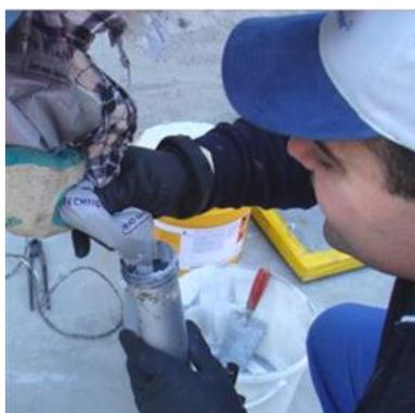
Nach dem Mischen wird der Klebstoff in Kartuschen gefüllt, um mit den Klebepistolen aufgetragen zu werden (siehe Bild links). Wenn Klebepistolen mit einem Metalllauf bzw. entsprechenden Kartuschen verwendet werden, wie Dichtmassenpistolen, die auch für Wurstopackungen genutzt werden, sind diese anschliessend unverzüglich mit Sika® Colma Reiniger zu reinigen, da sich ausgehärteter Klebstoff nur mechanisch entfernen lässt. Alternativ können Einwegkartuschen aus Kunststoff verwendet werden.
