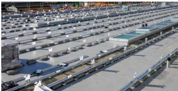
Das Hybrid-TPO-Dach ist höchst widerstandsfähig und bildet die solide Basis für die Fotovoltaik-Anlage.
