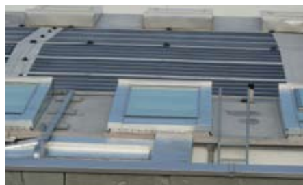
Spezielle Oberlichter sorgen für Tageslicht im Saal.
