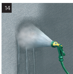
Bagnare la superficie in calcestruzzo Saturare con acqua i pori del calcestruzzo.
