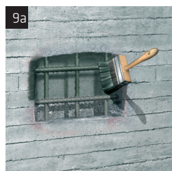
Ponte adesivo SikaTop Armatec 110 EpoCem/ Sika MonoTop-1010
