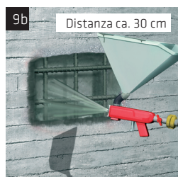
Ponte adesivo e protezione anticorrosione Spruzzatura con pistola a imbuto. Osservare la regolazione dell'ugello.
