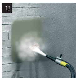
Preparazione del sottofondo per la rasatura
