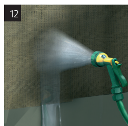
Trattamento successivo Juta umida, telo di plastica aderente mantenuto umido.
