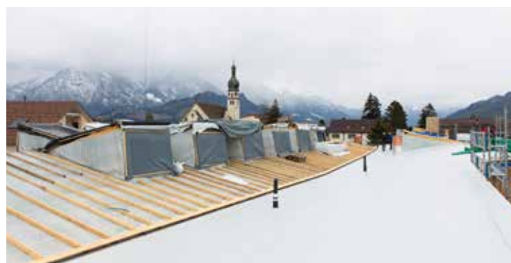
Auch bei wechselhaftem/nassem Wetter konnte das geneigte Dach sicher abgedichtet und auch betreten werden, dank der hohen Rutschfestigkeit von SikaRoof AT.
