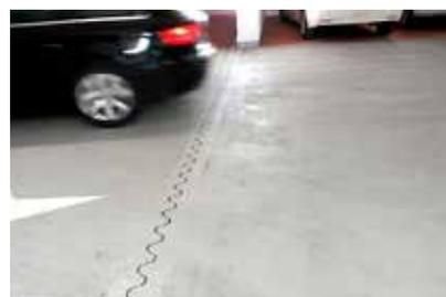
Il faut prêter une attention toute particulière aux raccords et aux joints de sols afin que les systèmes pour parkings Sikafloor® puissent remplir entièrement leurs fonctions. L'exécution correcte des détails est capitale pour la durabilité de l'étanchéité.
