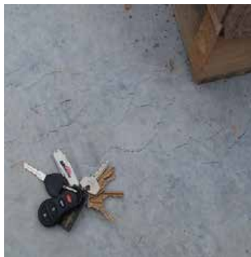
Abb. 5.2.1.2: Plastische Senkungsrisse unter einem Bewehrungsstab
