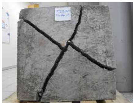
Abb. 8.2.1.2: Ansicht der Unterseite der geprüften quadratischen Platten
