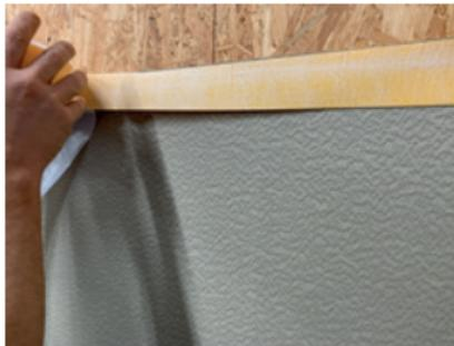
Bei kühlen Temperaturen zur Erhöhung der Frühhaftung SikaProof® Bonding Tape aufkleben
