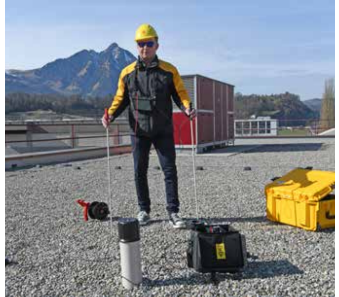
Niedervolt-Prüfung: Dach muss FEUCHT / NASS sein!
