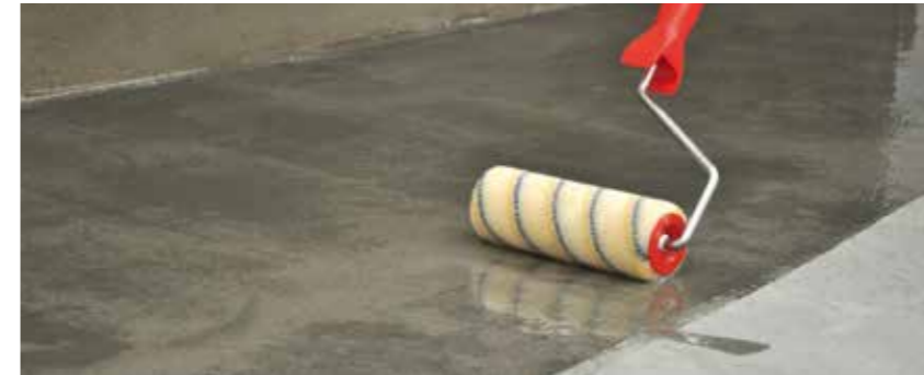
Die Grundierung Sikafloor®-160 mit einer Kurzflorrolle aufbringen.
