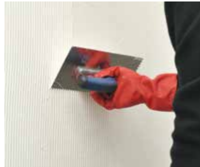
Die Polyurethan Abdichtung SCHÖNOX® EA PUR S mit einer 4er Zahnung aufbringen.
