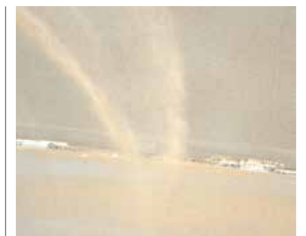
Die Fläche in der Frischphase des Material mit Sikadur®-501 (Quarzsand 0.3 - 0.9 mm) absanden und nach Trocknung absaugen/abkehren.
