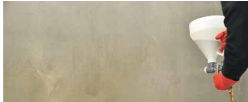
Absanden der grundierten Fläche mittels Trichterpistole mit Sikadur®-501 (Quarzsand 0.3 - 0.9 mm).
