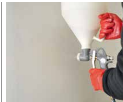
Absanden der abgedichteten Fläche mit Sikadur®-501 (Quarzsand 0.3 - 0.9 mm) in der Frischphase des Materials.
