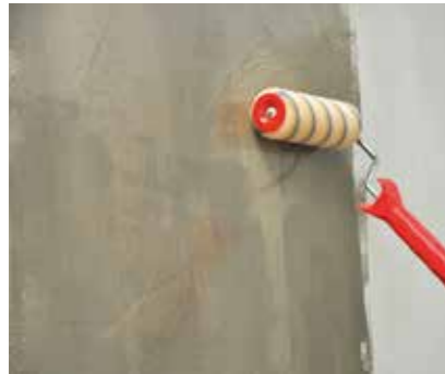
Die Grundierung Sikafloor®-160 mit einer Kurzflorrolle aufbringen.
