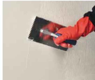
Die aufgebrauchte SCHÖNOX® EA PUR S-Zahnung mit einer Kelle abglätten und die Schichtdicke prüfen.
