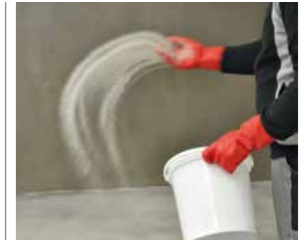
Die grundierte Fläche mit Sikadur®-501 (Quarzsand 0.3 - 0.9 mm) absanden.
