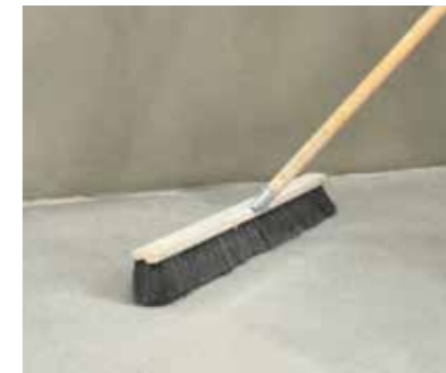
Absaugen/abkehren des überschüssigen Quarzsandes auf der durchgetrockneten Fläche.
