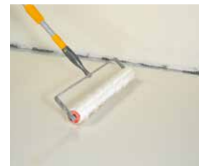
Die Abdichtung mit einer Stachelwalze (Stachellänge ca. 1 cm) abrollen und die Schichtstärke prüfen.
