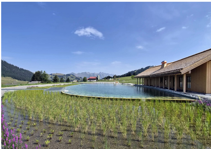
Un système de filtration biologique à base de plantes traite l'eau.
