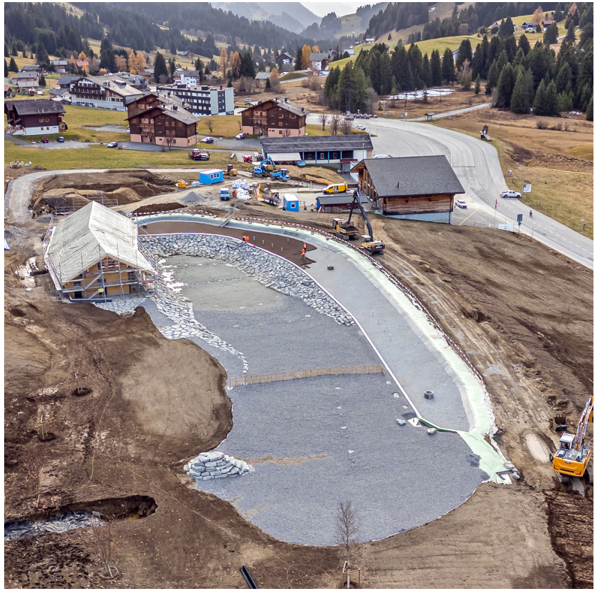
Les membranes d'étanchéité FPO Sikaplan® WT 5210 20 CE ont été déroulées sans tension sur le support préparé.
