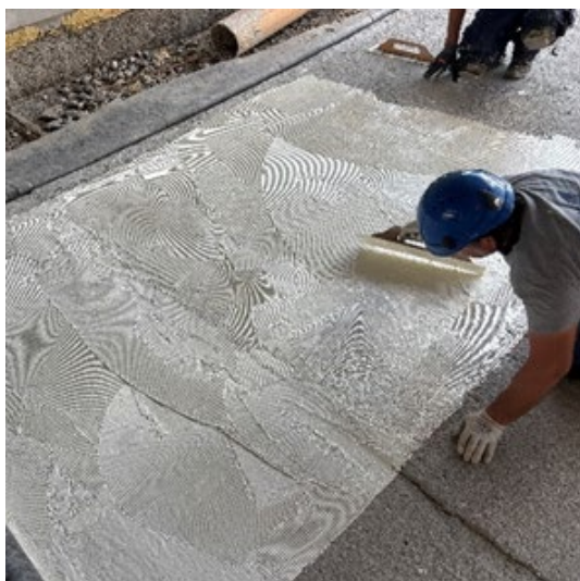
Fig. 4: Application de la colle à l'aide d'une truelle crantée
