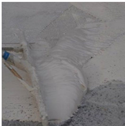
Fig. 5: Application de la colle à l'aide d'une racle crantée
