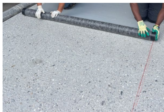
Fig. 2: Enroulement des lés après marquage de la zone de collage
