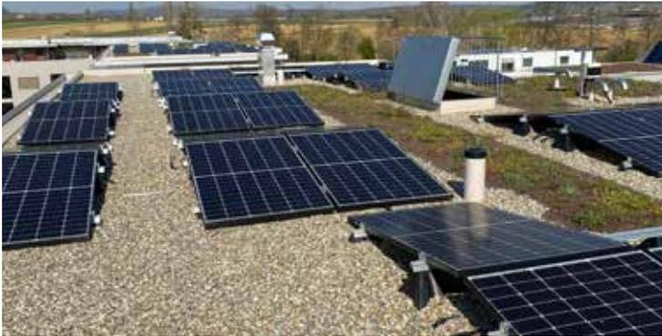
Die Hauptdächer sind bekies (Bereich PV-Anlage) und begrünt - beides ist mit derselben Sika® Abdichtung möglich.
