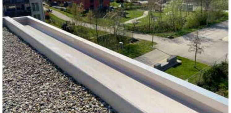
Die Hauptdächer werden durch eine rundherum geführte Rinne entwässert - diese ist ebenfalls zuverlässig mit Sarnafil® TG 66-18 abgedichtet.
