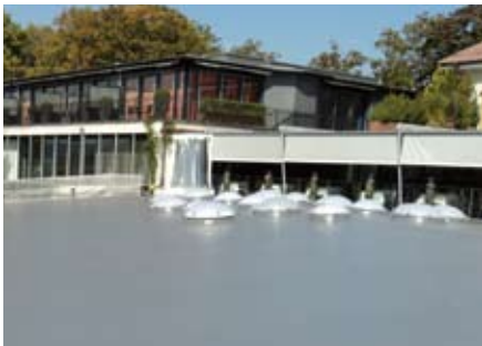
Durch die gut dehnbare Sarnafil-Abdichtung und dank dem Know-how des Verlegers konnten die Oblichter erfolgreich abgedichtet werden.
