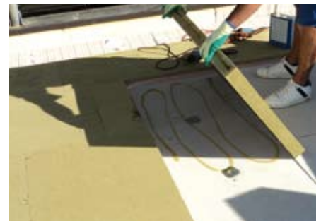
Verklebung der Steinwolldämmplatten auf die mechanisch befestigte Sarnapur-Dämmung
