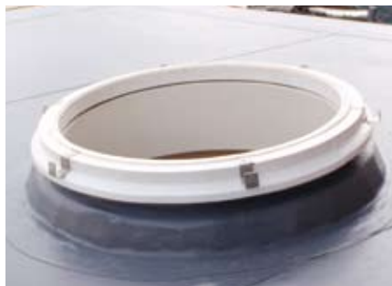
Durch die gut dehnbare Sarnafil-Abdichtung und dank dem Know-how des Verlegers konnten die Oblichter erfolgreich abgedichtet werden.
