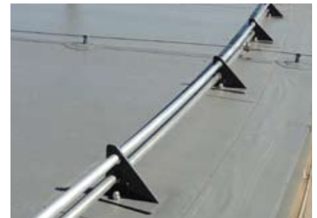
Der durchgehende Schneefang verhindert das Abrutschen des Schnees.
