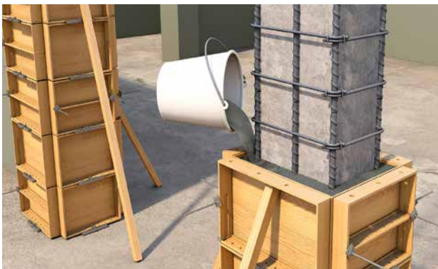
Completamento della sezione trasversale mediante colatura
