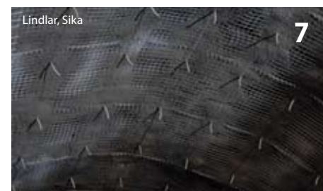
Rasterweises Einspritzen der Rückprallreduktionsmaßnahme
