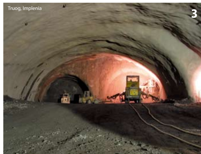
Abdichtungsträger im Bereich der Aufweitung
