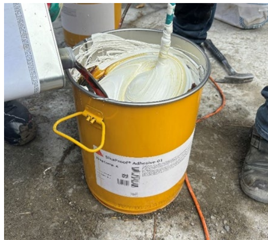
Fig. 3 Miscelazione dell'adesivo.
