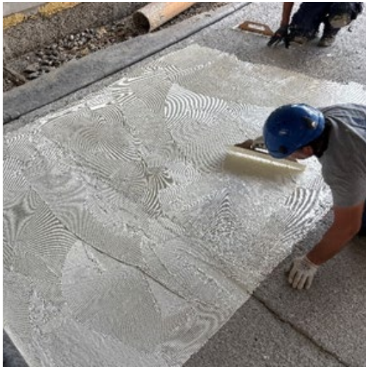
Fig. 4 Applicazione dell'adesivo con frattone dentato.
