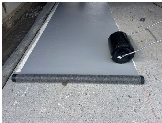
Fig. 7 Compressione di SikaRoof® AT.
