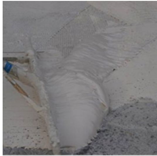
Fig. 5 Applicazione dell'adesivo con racla dentata.
