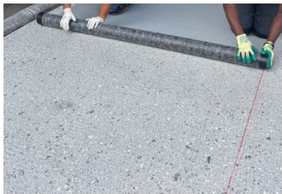
Fig. 2 Dopo aver contrassegnato l'area di incollaggio, le strisce di membrana vengono riarrotolate.
