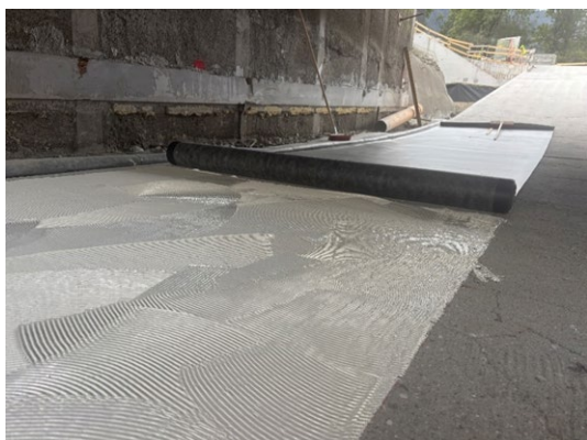
Fig. 6 Allettamento di SikaRoof® AT.
