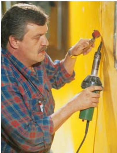
Mise en œuvre Sarnafil G 465-15 avec l'appareil à souder à air chaud.
